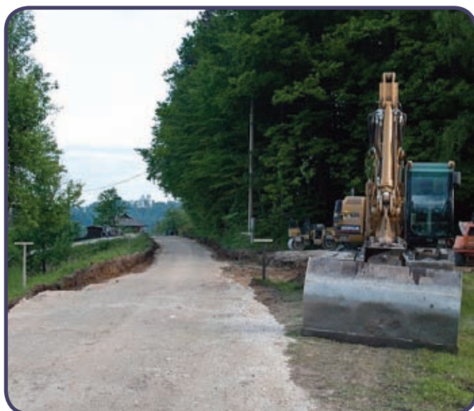
Utrjevalna dela cestišča proti Vrhovju
