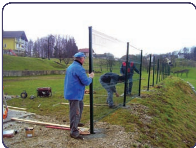
Postavitev zaščitne ograje pri šoli
